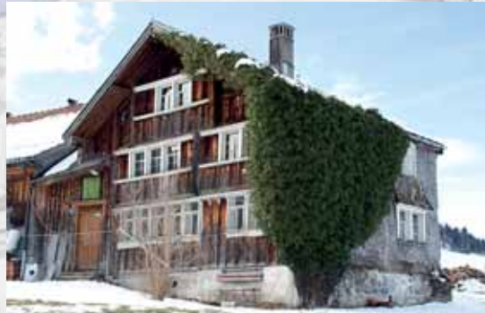
Strickbau in Appenzell, Schweiz
