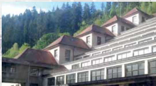
Terrassenbau in Schramberg (Arch. Manz / Firmengebäude Junghans)
